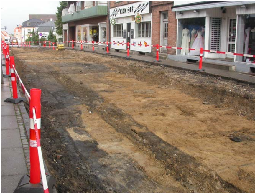
SVM2004029: oversigt over udgravningsfeltet med de mange nedgravede ledninger
