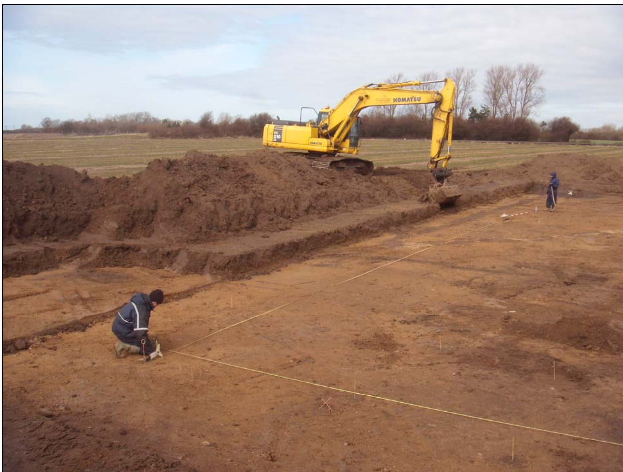
Foto: 01258D58. Gravemaskinen afrømmer muldlaget i den vestlige del af felt 2, samtidig med at indmålingsarbejdet foregår.
