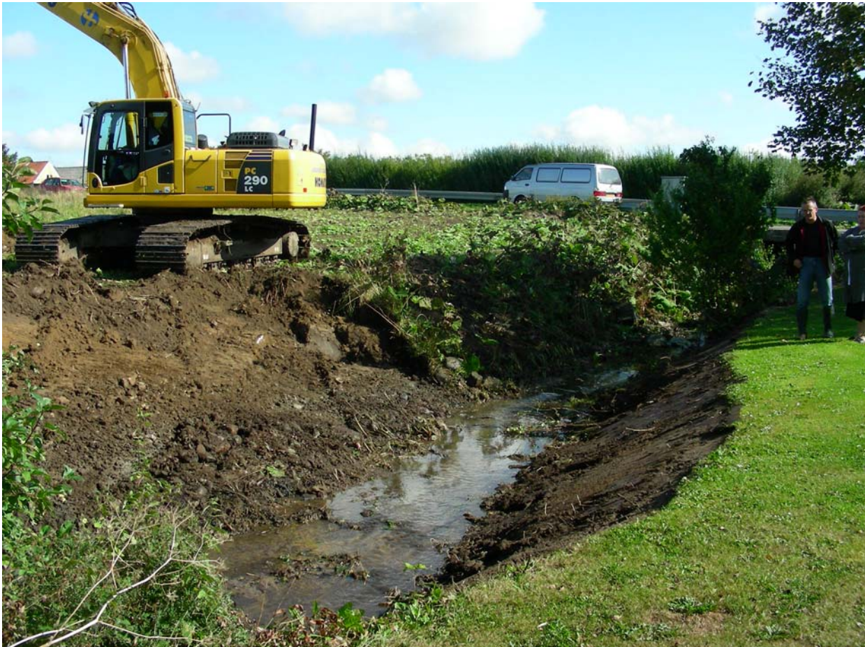
SVM 01294D06. Gravemaskinen arbejder på det område, hvor der skal etableres et sandfang. I baggrunden Farendløsevej. Set fra vest d. 15. september 2009.
