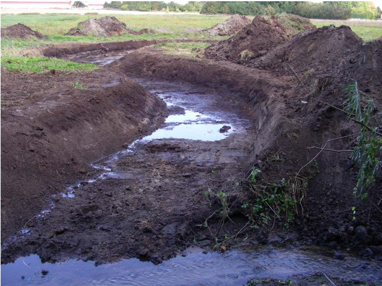
SVM 01294D10. Parti af den nygravede slyngning nord for åen, set fra syd. Man bestræber sig på at genskabe en lign. slyngning der fandtes i en dog lidt større udgave på dette sted frem til begyndelsen af 1800-tallet. Jvf. det indsatte kortudsnit på side 6.
