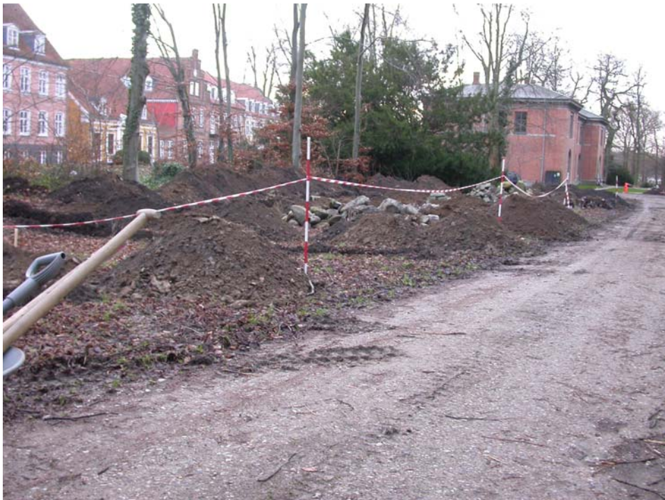
01058D04: søgegrøfter på det nordlige byggefelt, set fra nordvest
