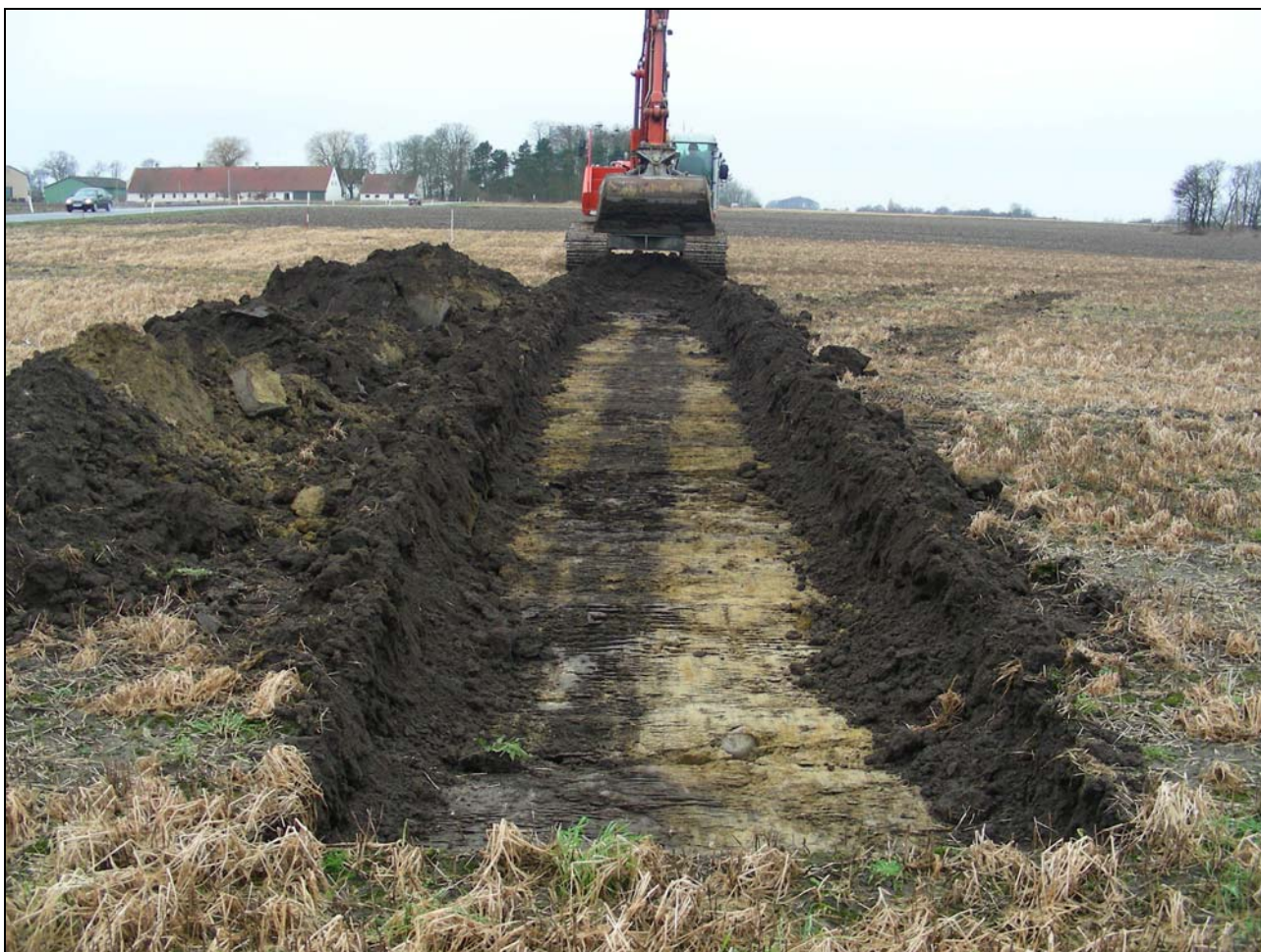
Den nordlige af de to søgegrøfter set fra øst – bemærk den mørkere gennemgående drænledning
