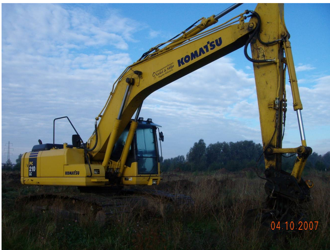
Gravemaskine brugt ved afømning af muldlag (Foto nr. 01140D02).
