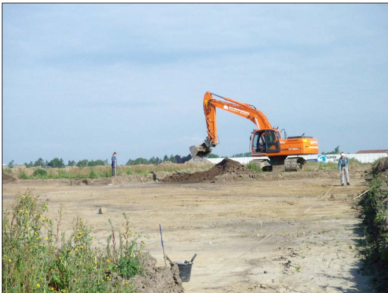
Foto: Udgravningen er i gang på Kærup Parkvej. (SVM d. 8/6 2008.)
