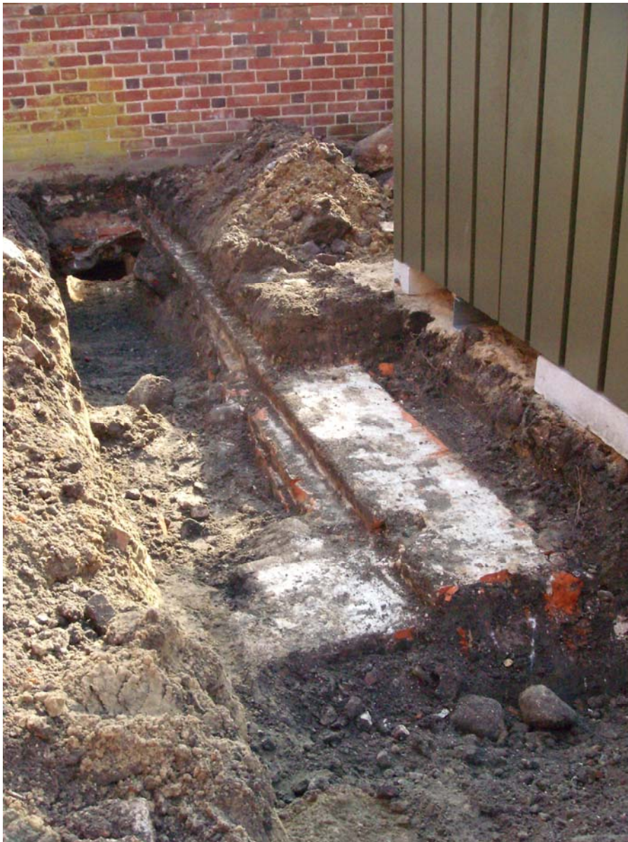
SVM01178D028: Det frilagte murparti i gårdhaven set fra nord. Bemærk hullet under muren, hvor ledningstracéet løber.
