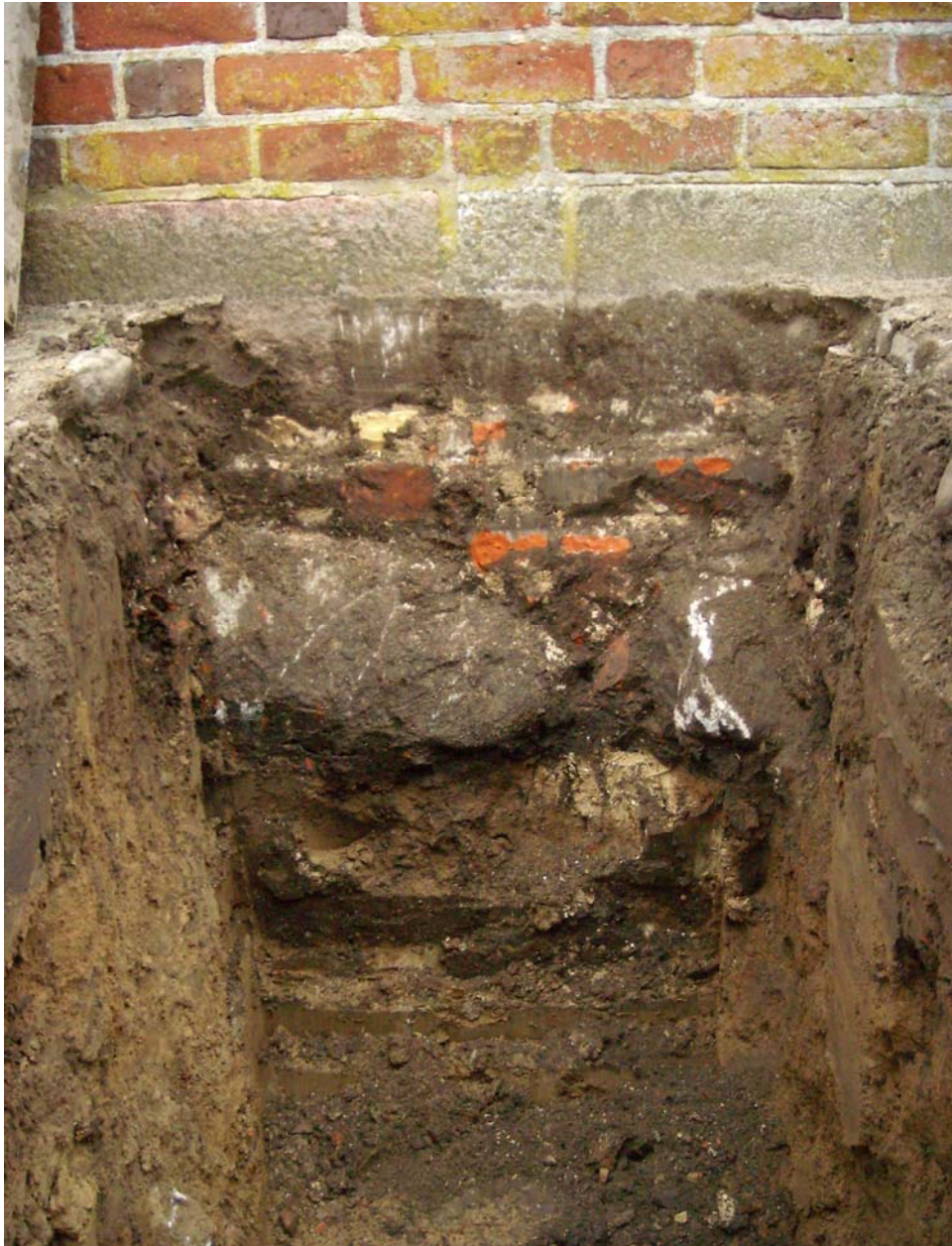
SVM01178D011. Rester af teglstensmur og kampestenssyld under nuværende gårdhavemur, hvor tracé går under.
