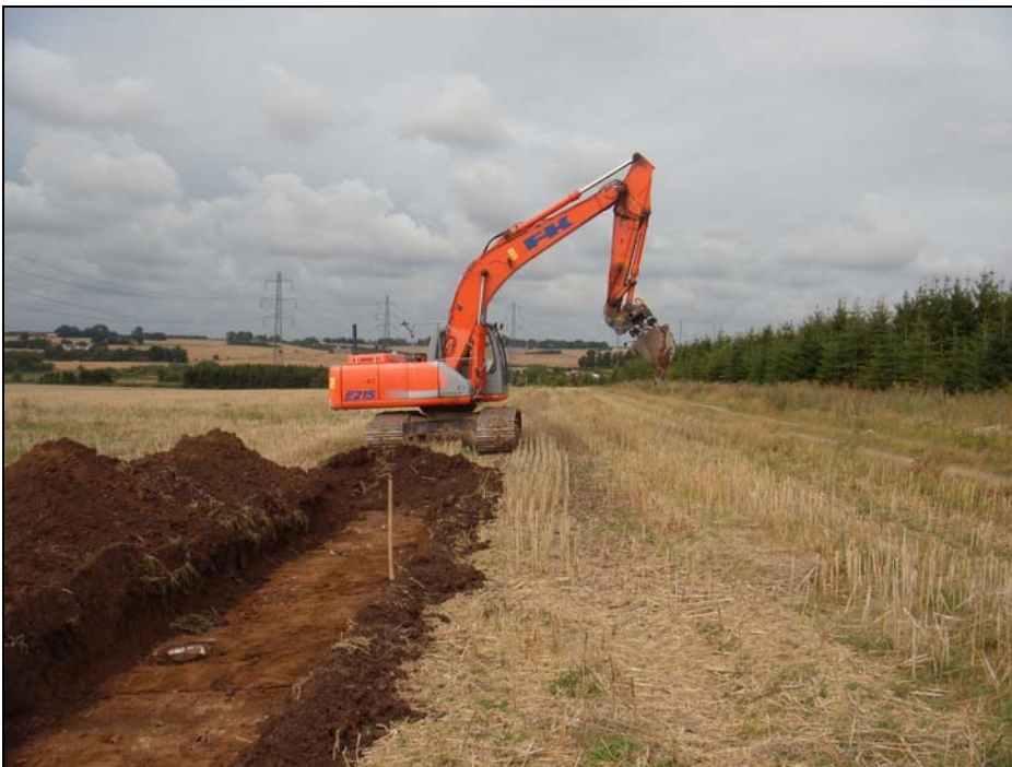
Foto: 01214D04. Arbejdsbillede fra opstarten af grøft 1.
