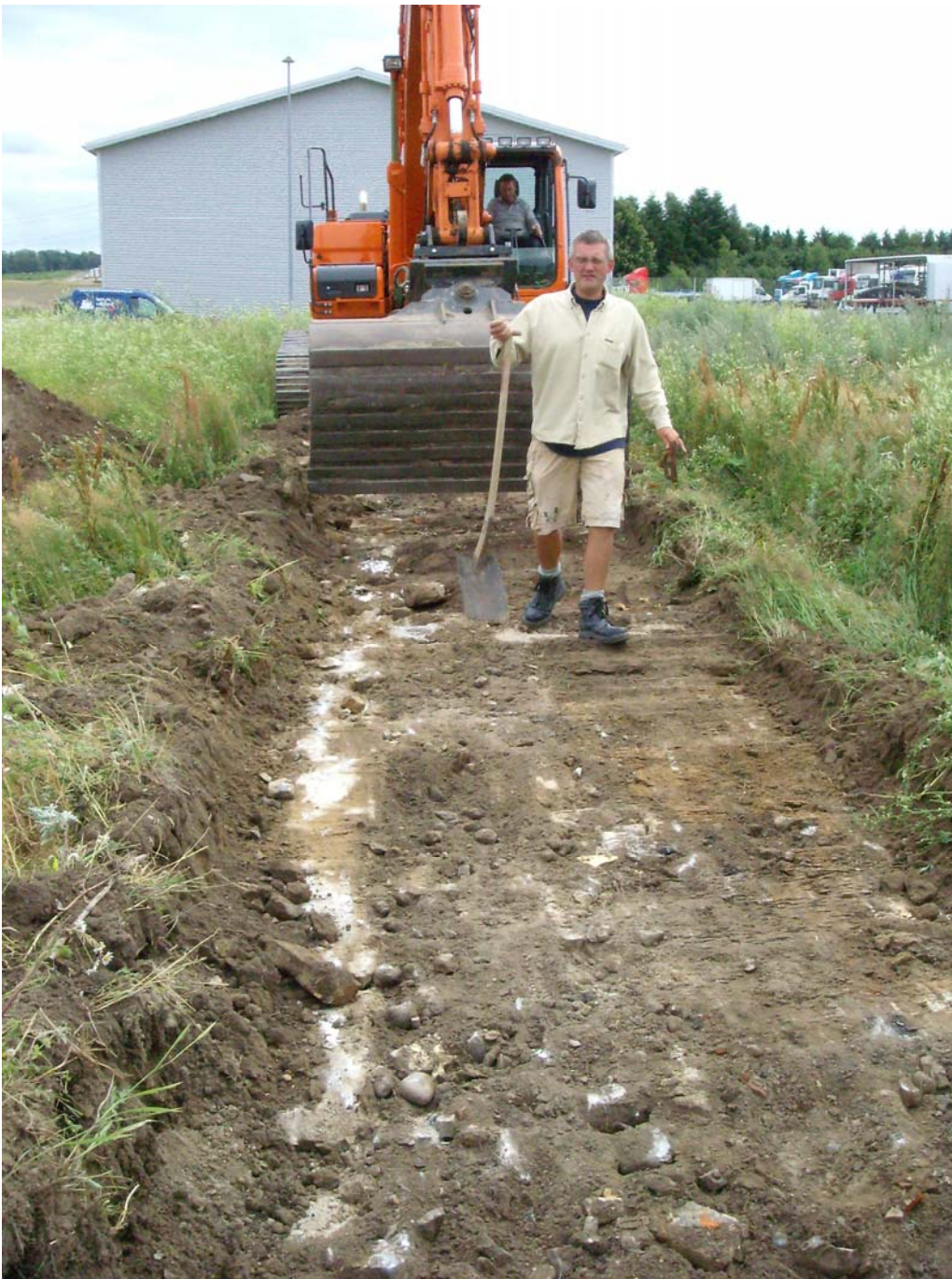
Foto 1. SVM01216-1. Grøft med fundamentrester og affald fra gårdens nedrivning (Foto: SVM)
