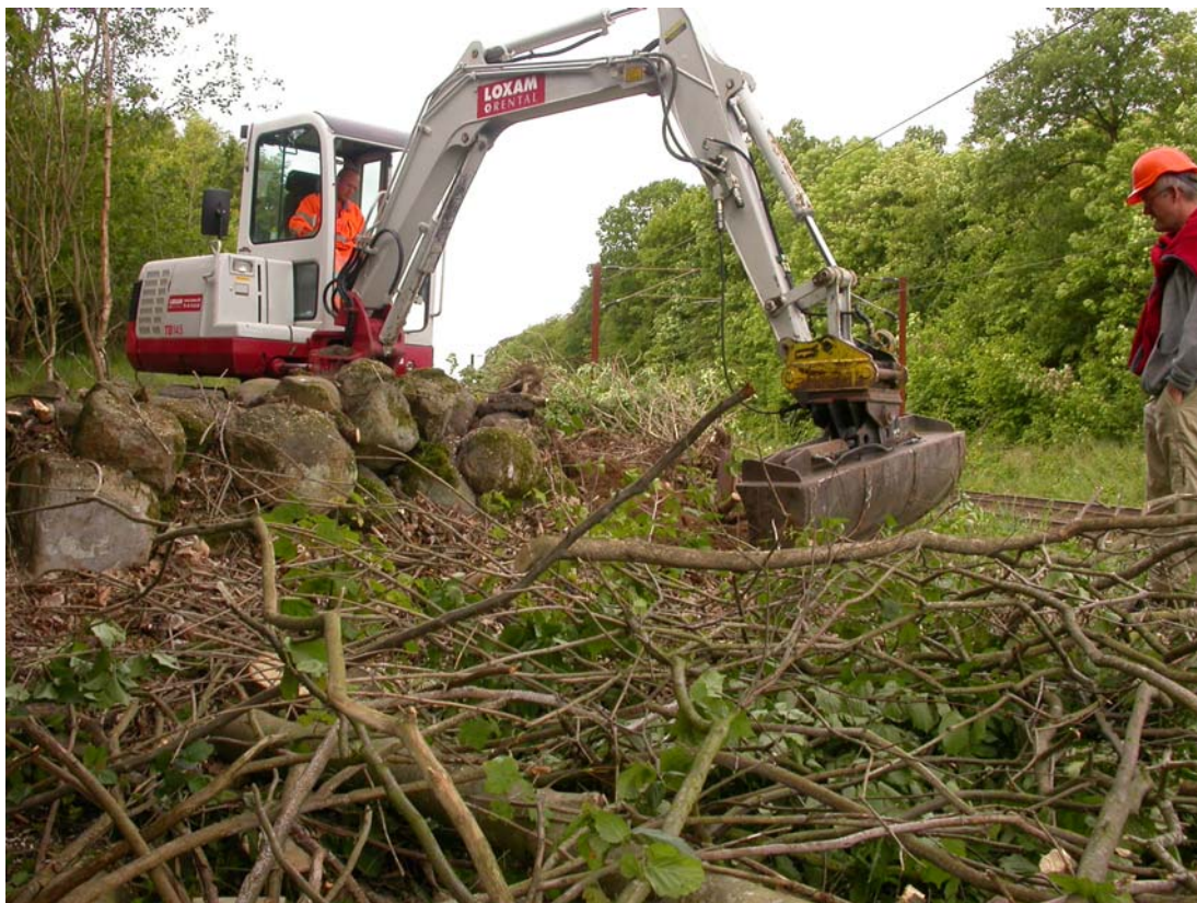
01280D23: gennembrydningen af den nordlige del af diget. I forgrunden dækker grene og kvas den stenbunke, som ikke er en del af diget
