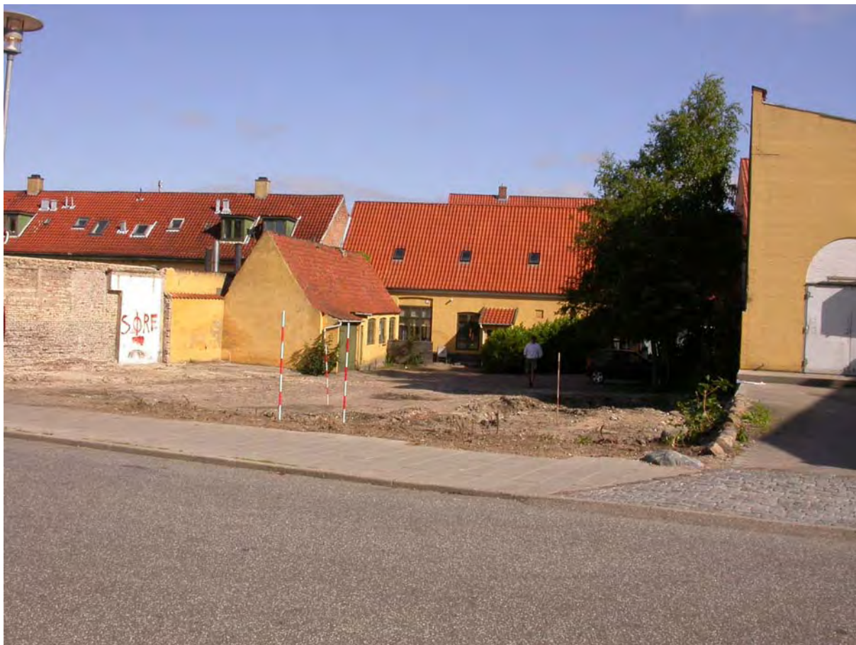
01282D01 den undersøgte grund set fra Bakkenborgvej
