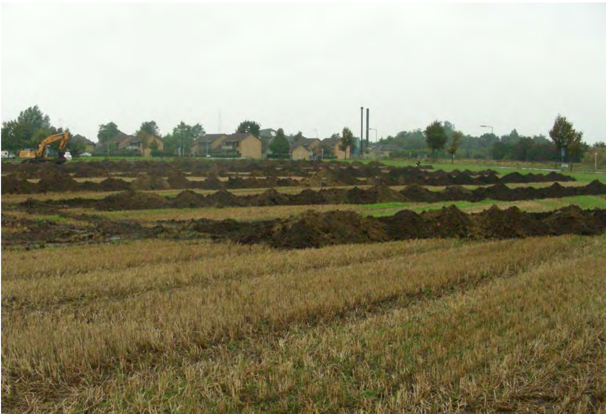
1345D07: det prøvegravede areal med søgegrøfter, set fra sydøst
