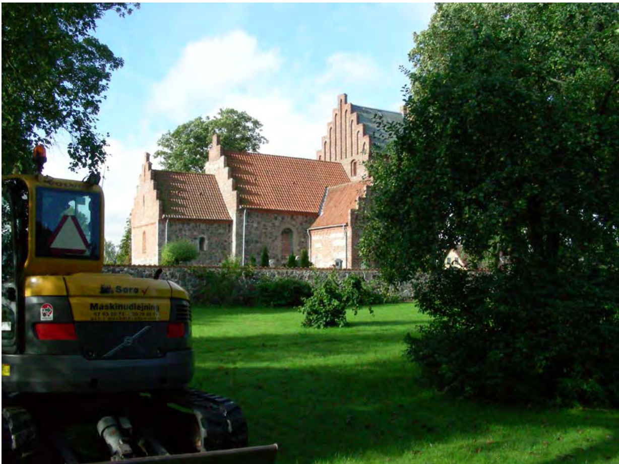
01347D07: Gravning af søgegrøfter lige nord for Stenlille kirke
