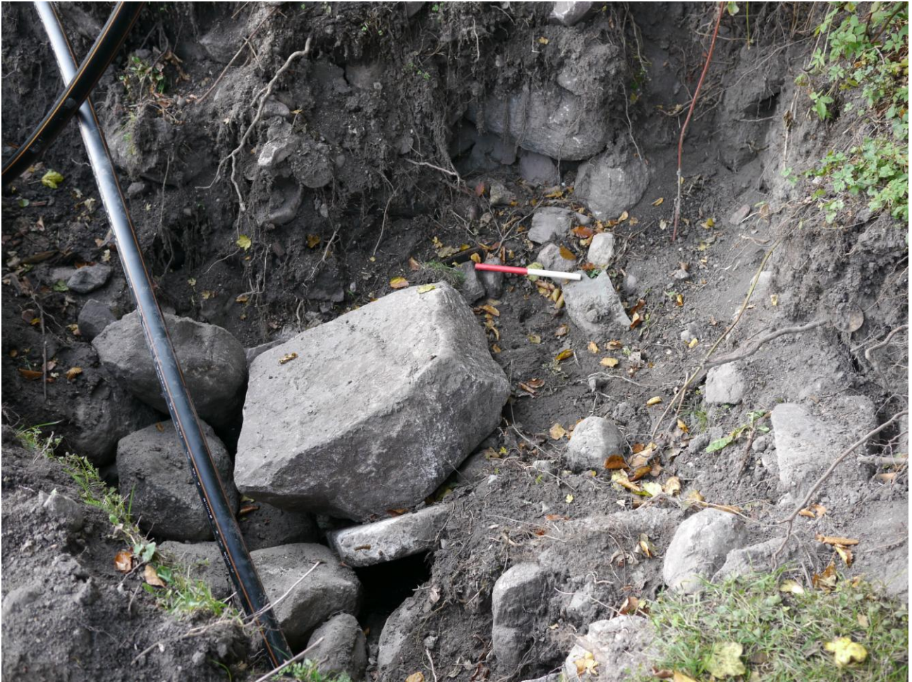
SVM1353D1. Nedgravning med denstensatte brønd skjult under større sten og armeret beton. Stenene i baggrunden er fra et sensat dige langs landsbygadens vestside. De to plastrør er nye tryksatte spildevandsledninger, der i øvrigt er nedlagt med styret gennemboring. Foto er optaget fra nordøst.
