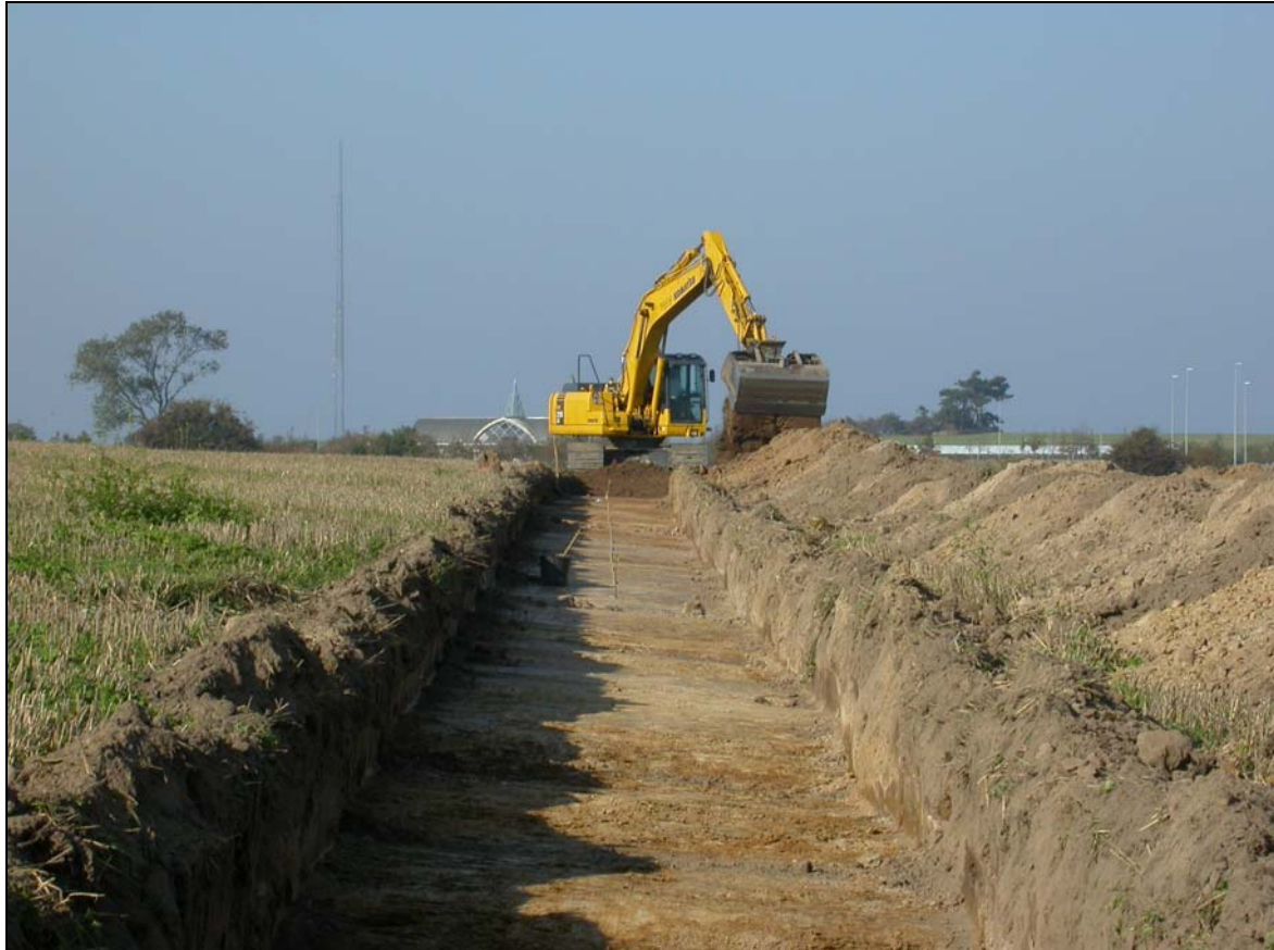
Gravemaskinen arbejder ved grøft 8 d. 13/10-2005. Til venstre skimtes Korsør Station.
