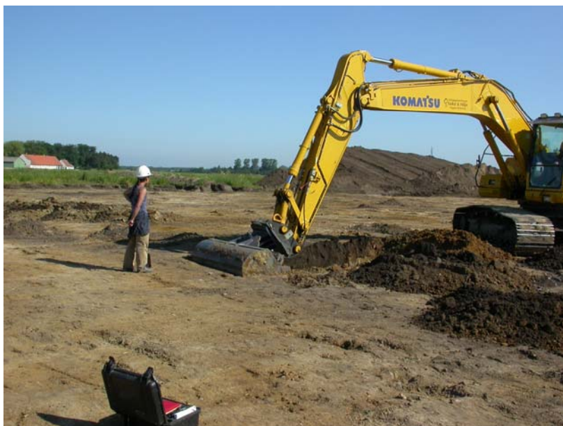
Snitning af anlæg med maskinkraft
