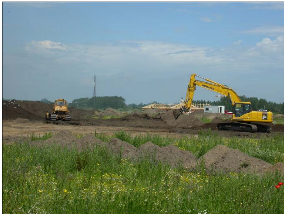
Gravemaskine og dozer afrømmer muld i felt 01
