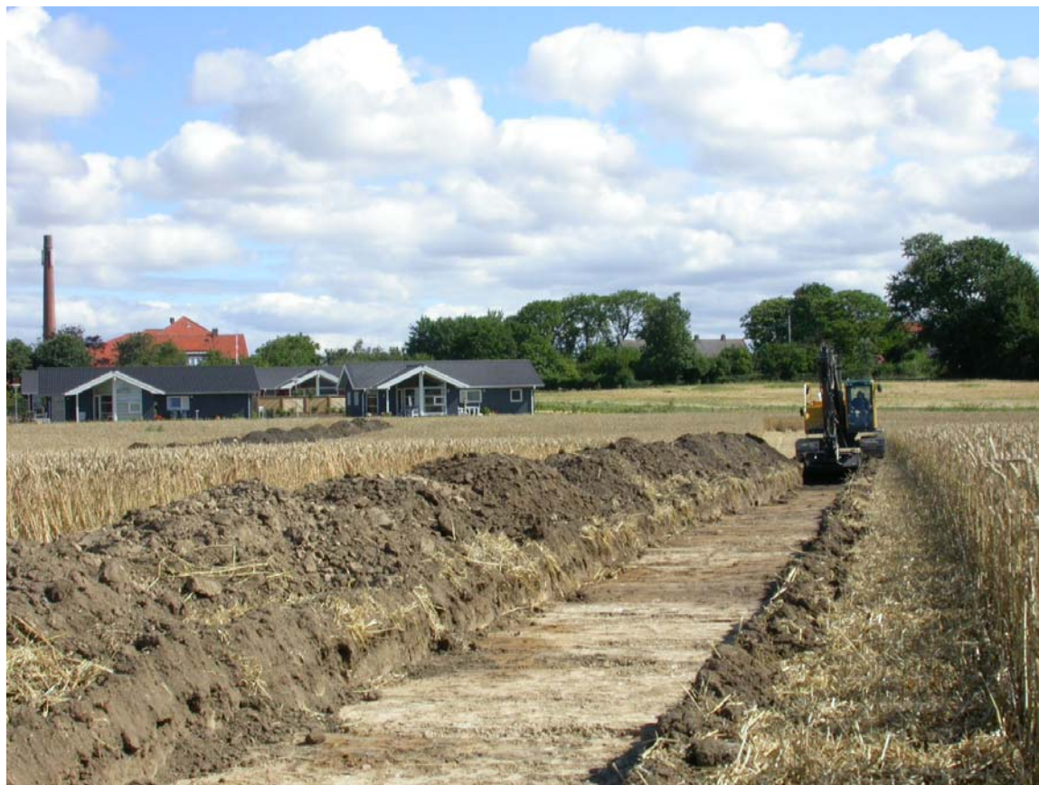
Gravemaskinen arbejder ved grøft 6 d. 26/7-2005
