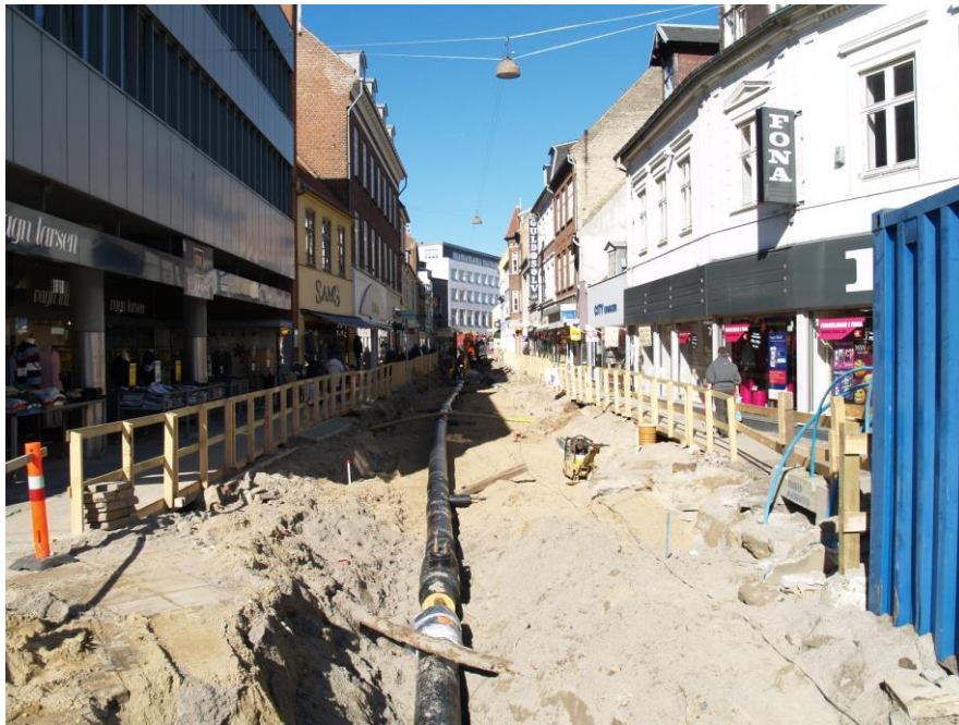
Østergågade under ledningsarbejdet set fra Lilletorv 20. marts 2007 FMN1423F0004
