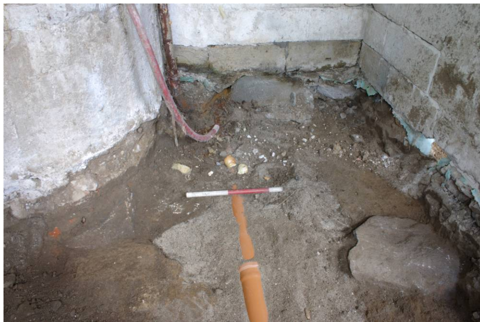
Kampestensfundamentet fortsætter – kun afbrudt af kloakken – ind under gruekedlen og boligen.
