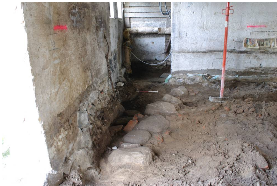
Kampestensfundamentet set fra vest løbende ind under skillevæggen.
